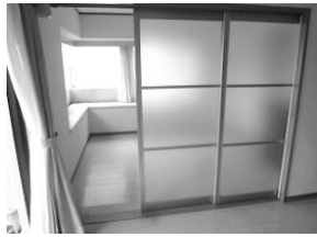
ガラス引き戸設置
